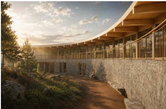
Granit-Sockel - vorgefertigte Holzkonstruktion
