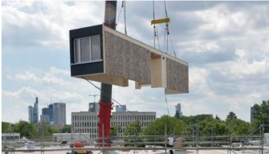
Vorgefertigtes Holzmodul während der Montage
