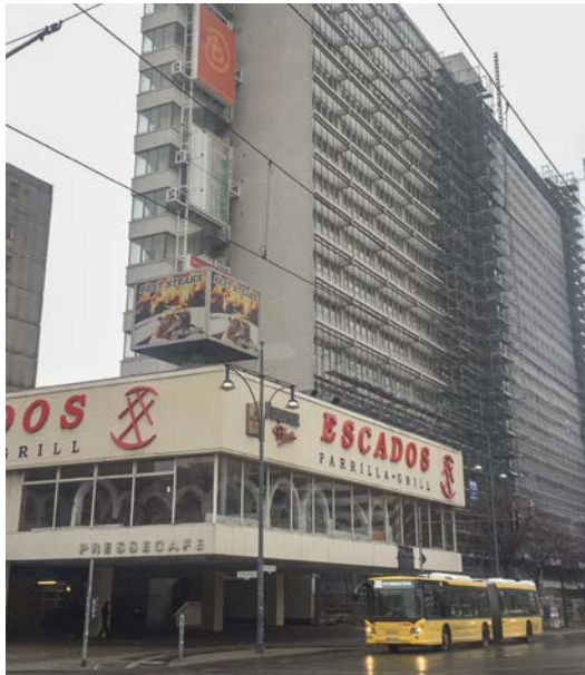
Während der Sanierung · 2020
