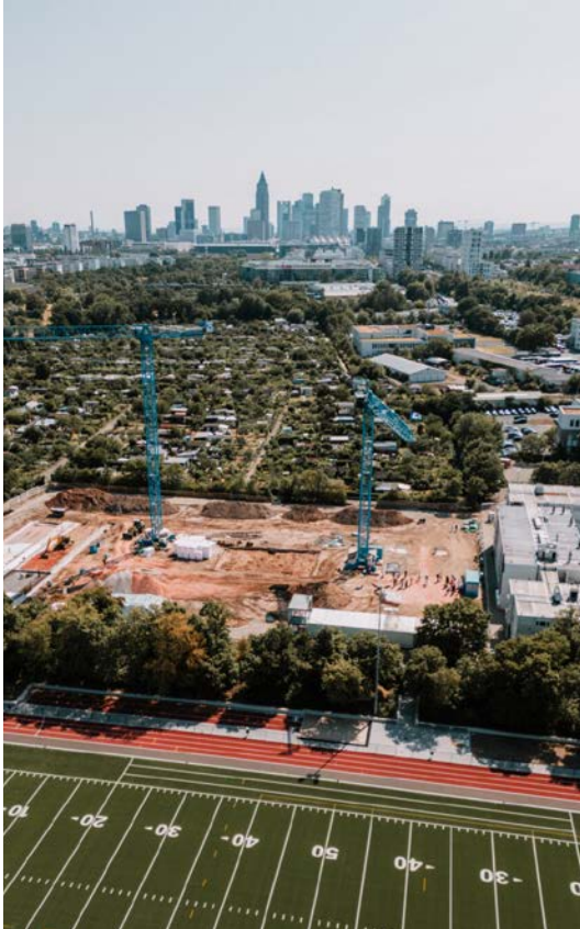
Baustelle Gymnasium am Römerhof, Frankfurt am Main
